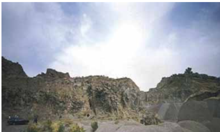
Figura 14. - Biancavilla. Cava di Monte Calvario prima dell'intervento di bonifica.
